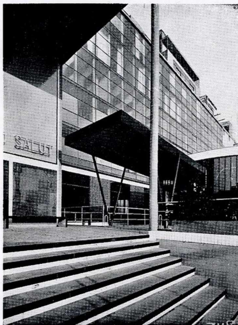
Fig. 3. — CITE DE REFUGE DE L'ARMÉE DU SALUT Chauffage sous vide. — Puissance 1.200.000 cal./H.
